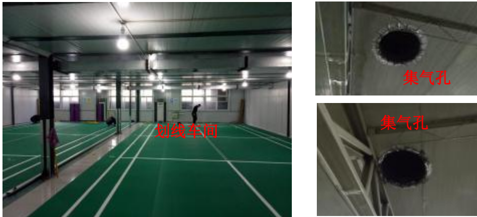
图 3-1 划线车间废气收集
